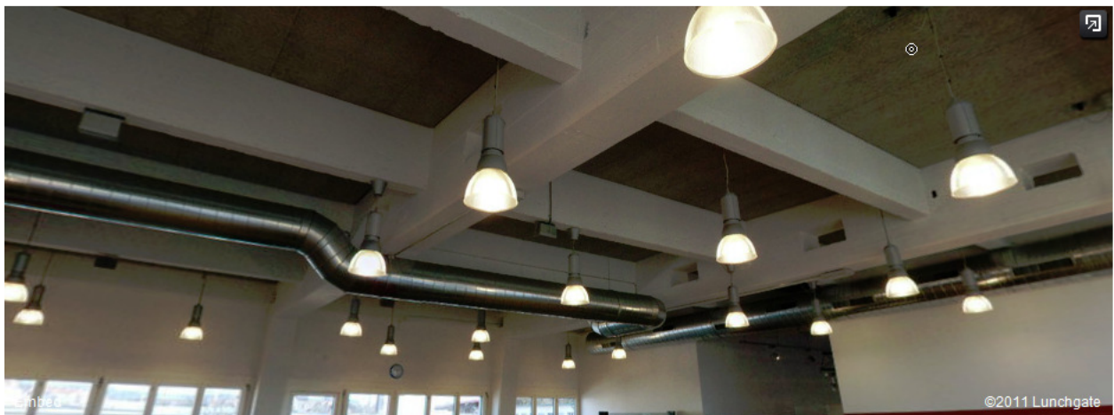
„Offene“ Decke mit sichtbaren Belüftungsrohren, Mediacampus, Badenerstr. 30, 8048 Zürich
